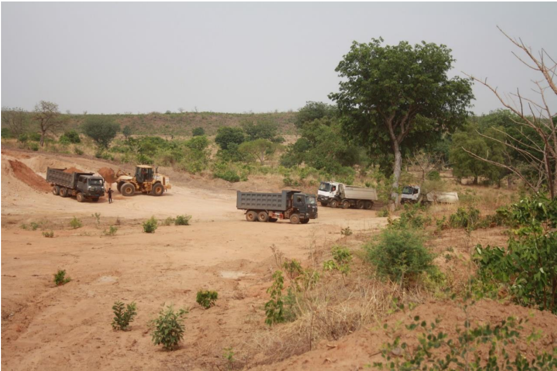
Figure 2 : Vue sur l'exploitation de la carrière PK 94, Guéwari (Abanga, 2024).
