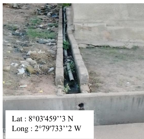
Photo 3b : Eau de bain raccordée au caniveau au quartier Labaya
